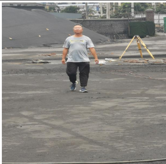
工程师现场踏勘
